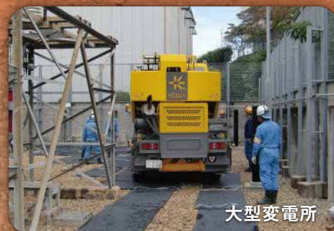
重機仮設駐車場
